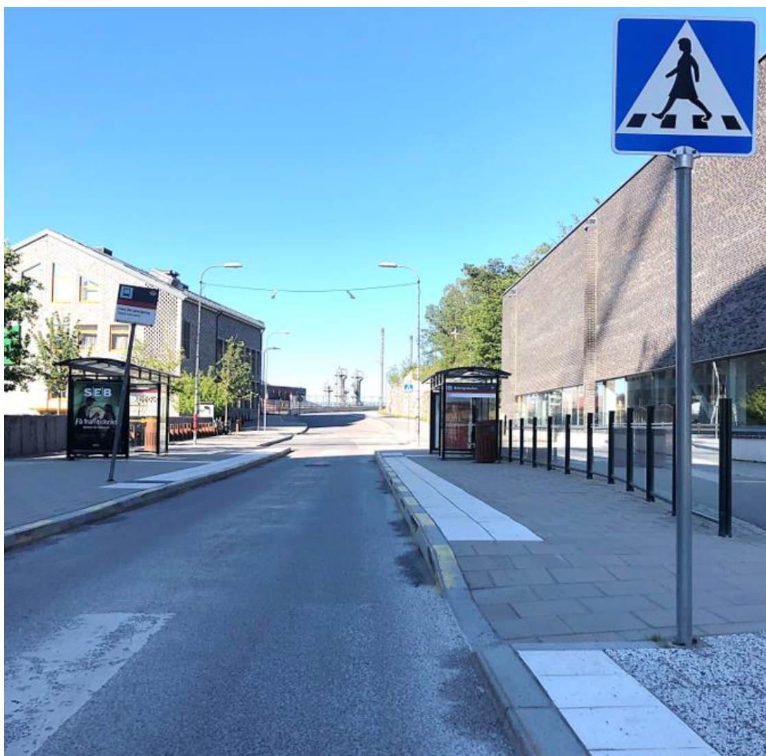
Figur 48: Exempel på utformning av timglashållplats med avsmalning av gatans körbana. Bild: Sweco 2025
