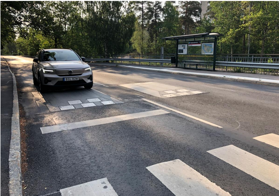
Figur 50: Exempel på placering av busskuddar vid övergångsställe i Lidingö stad. Bild: Sweco 2025
