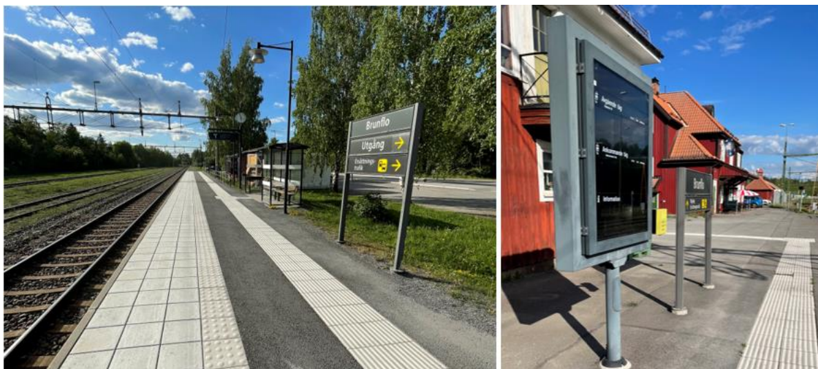
Figur 18: Bilder från platsbesök av Region Jämtland Härjedalen 2024
