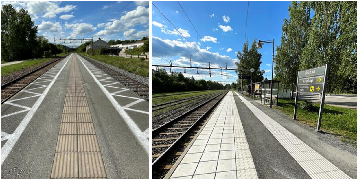
Figur 39: Exempel på målad linje respektive skyddszon med taktil och kontrasterande beläggning. Bild: Region Jämtland Härjedalen 2024
