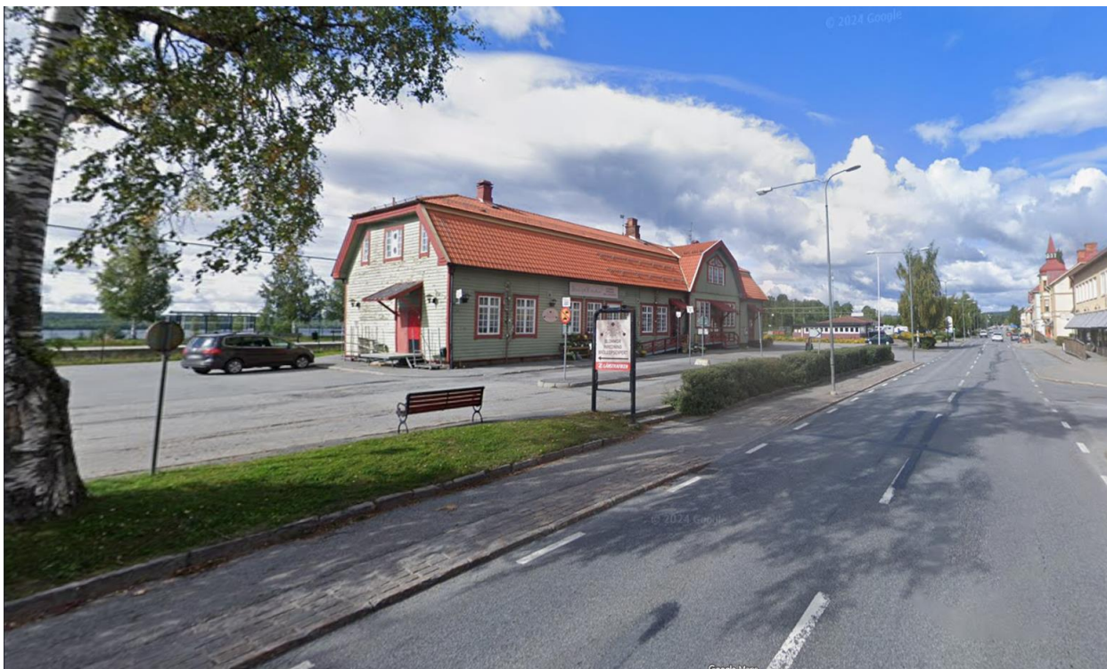
Figur 82: Nulägesbild Bräcke station, vy mot norr mot stationen. Källa: Google Street View 2025
