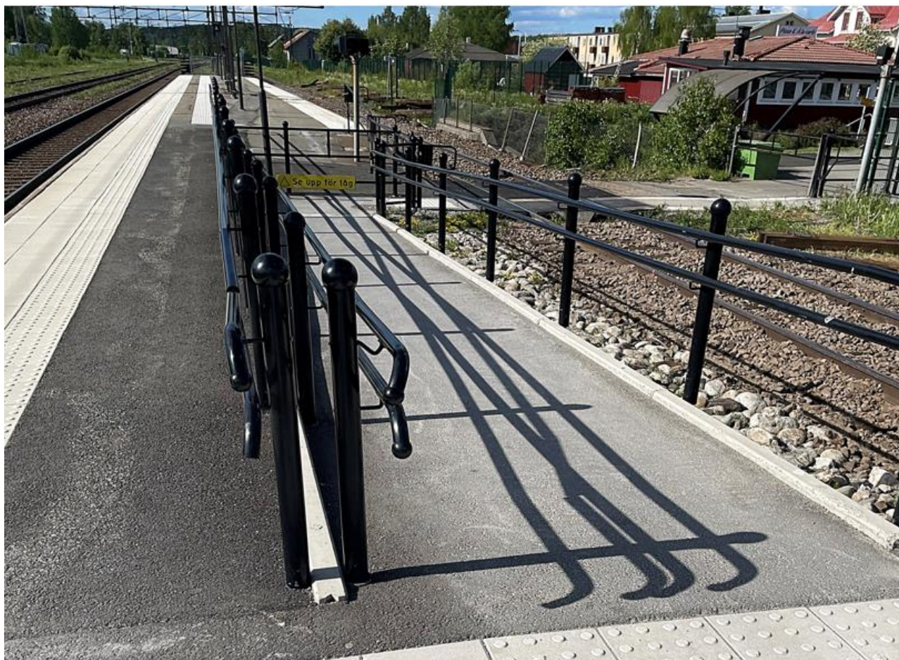
Figur 45: Ramp med varningsyta vid början och slut, dubbla ledstänger och avåkningskydd. Bild: Sweco 2025
