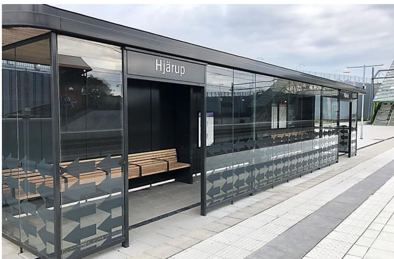
Figur 43: Exempel på klimatskyddat väderskydd med stängbara dörrar från Hjärup i Skåne. Bild: Sweco 2025
