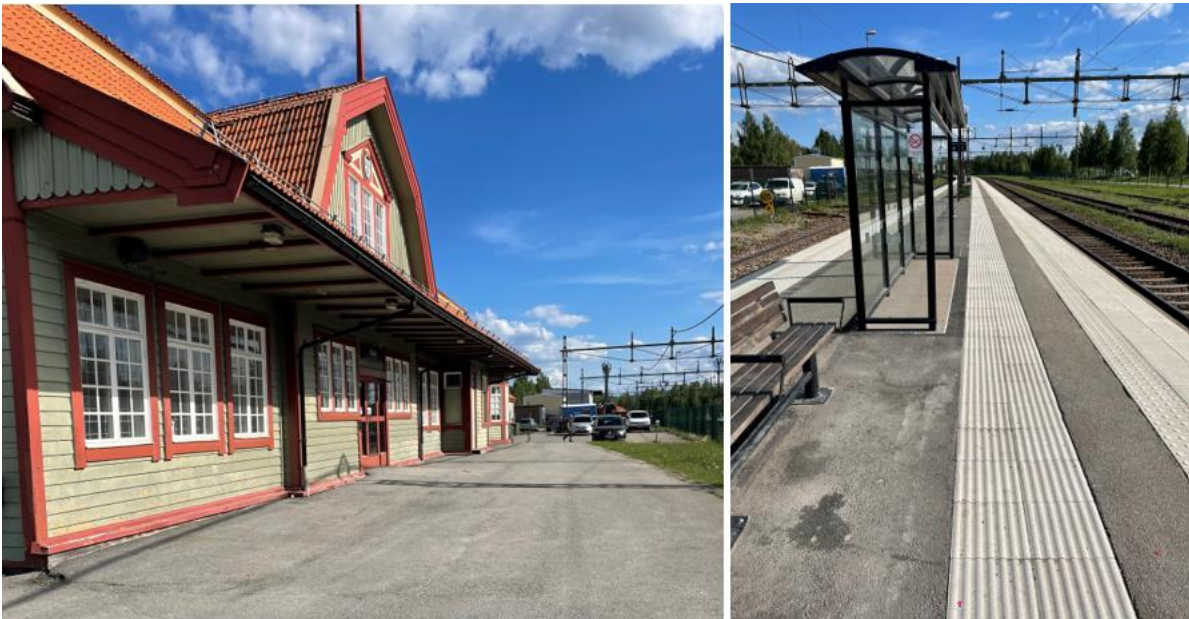
Figur 21: Bilder från platsbesök av Region Jämtland Härjedalen 2024
