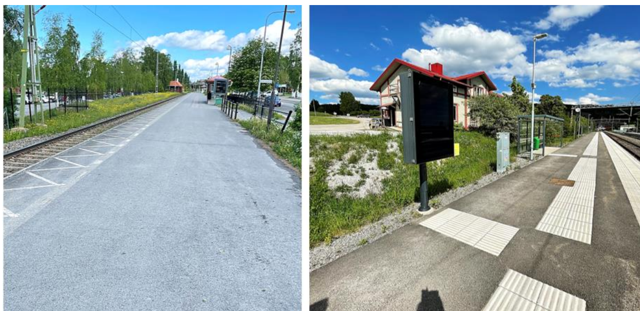
Figur 40: Exempel på plattform utan och med taktila ledstråk. Bild: Region Jämtland Härjedalen 2024
