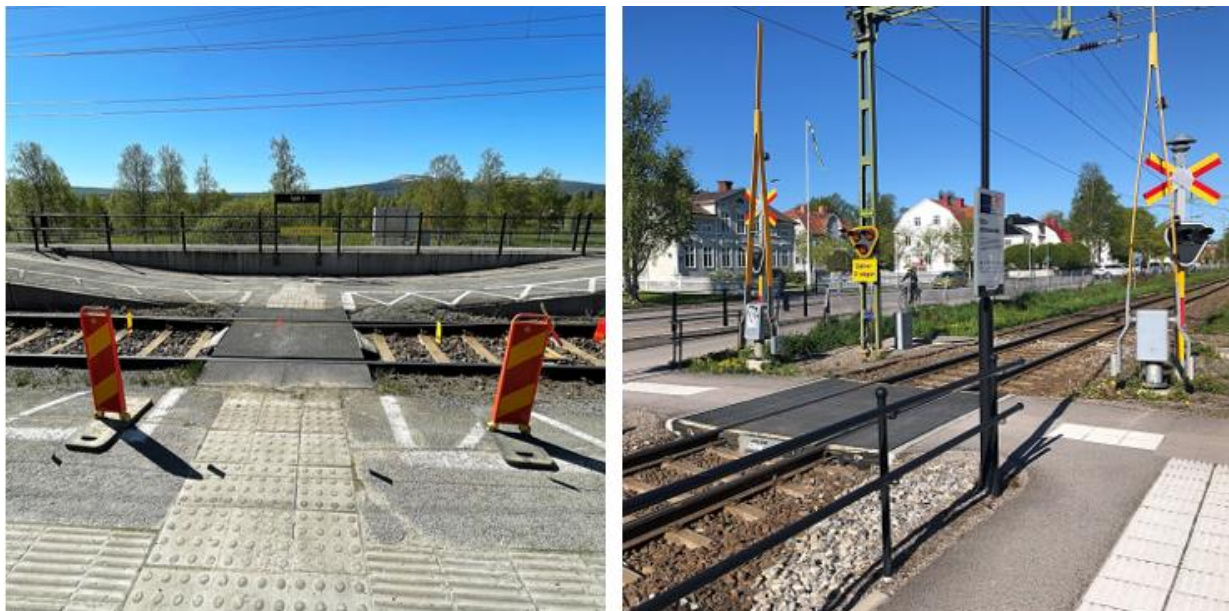
Figur 46: Obevakad plattformsförbindelse respektive bevakad med bommar och ljud- och ljussignal. Bild: Sweco 2025
