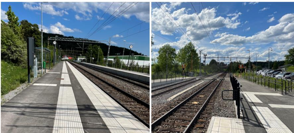
Figur 34: Bilder från platsbesök av Region Jämtland Härjedalen 2024
