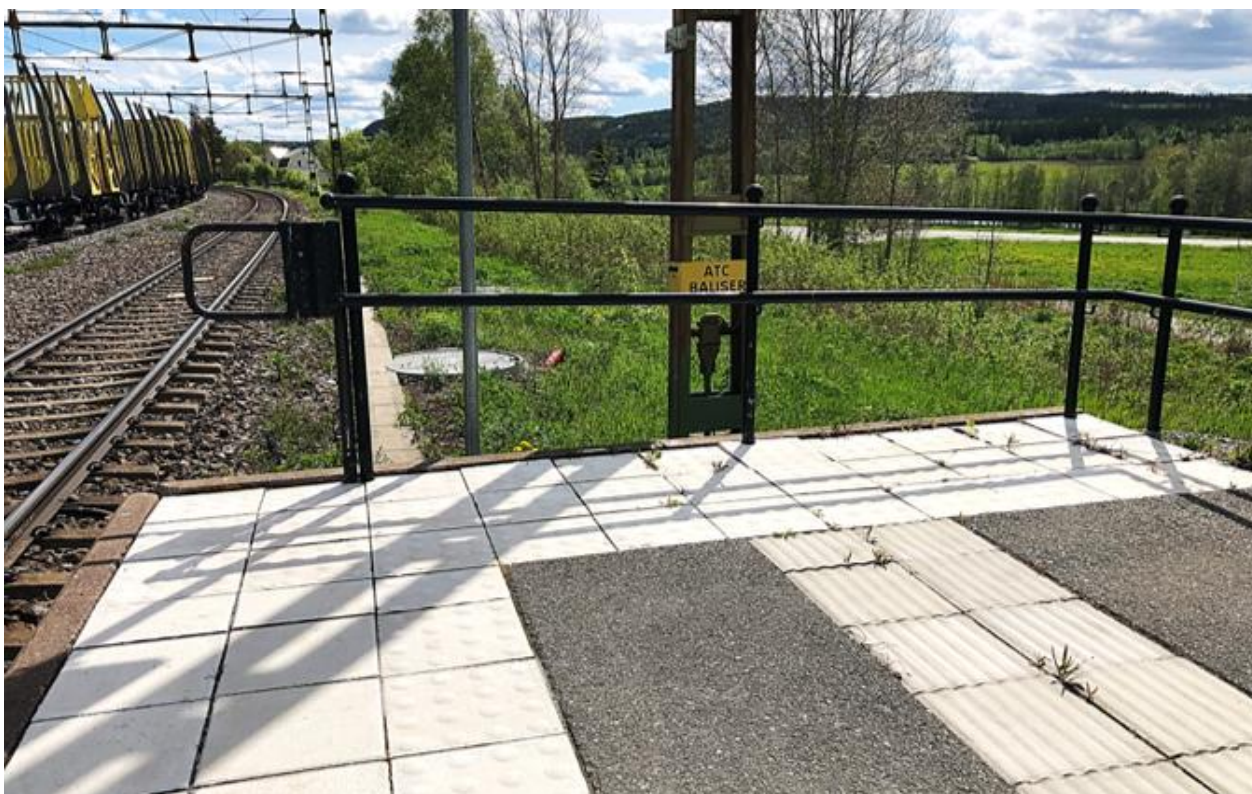
Figur 41: Exempel på plattformsslut med varningsplattor och grind. Bild: Sweco 2025
