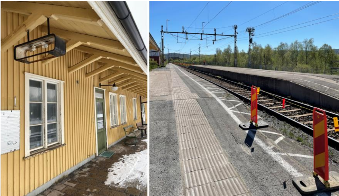
Figur 5: Bild till vänster från platsbesök av Sweco 2025 och till höger från platsbesök av Region Jämtland Härjedalen 2024
