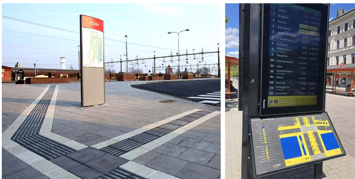
Figur 49: Exempel på taktila och visuella ledstråk till höger och taktil orienteringstavla till vänster. Bild: Sweco 2025
