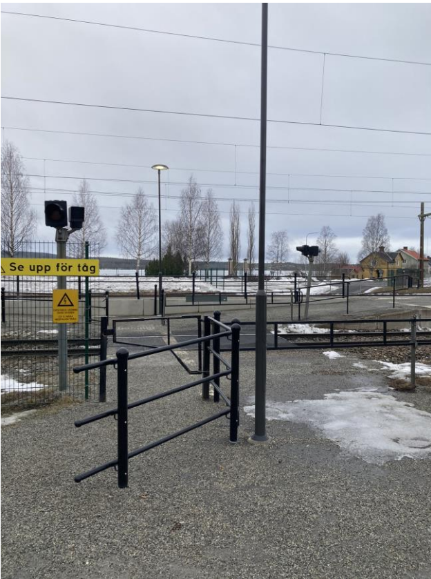
Plattform med kontrasterande skyddszon och taktila stråk.
