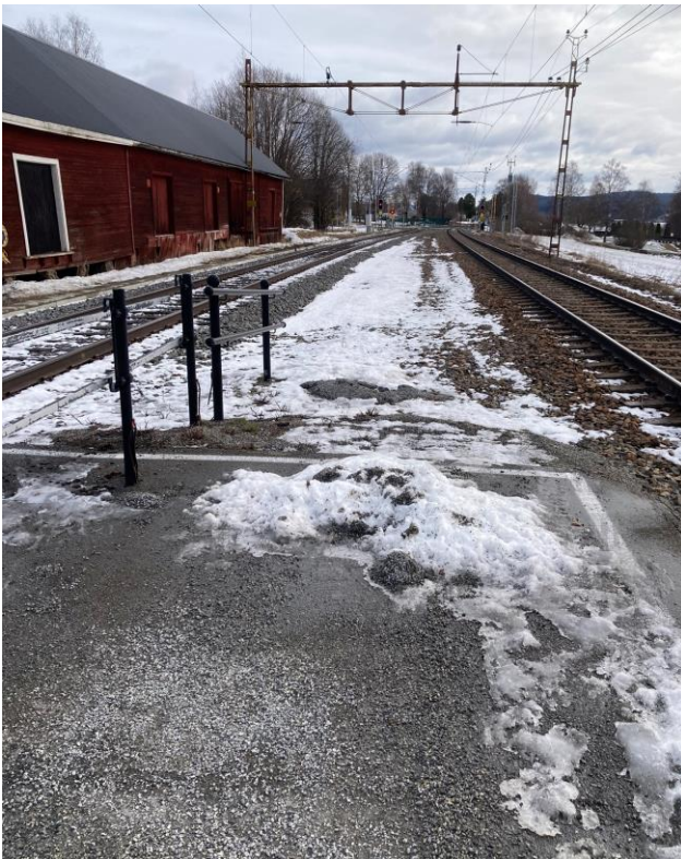
Det saknas kontrastmarkering och grind vid plattformens slut. Ramp har ej kontrastmarkering och ledstång på båda sidor.
